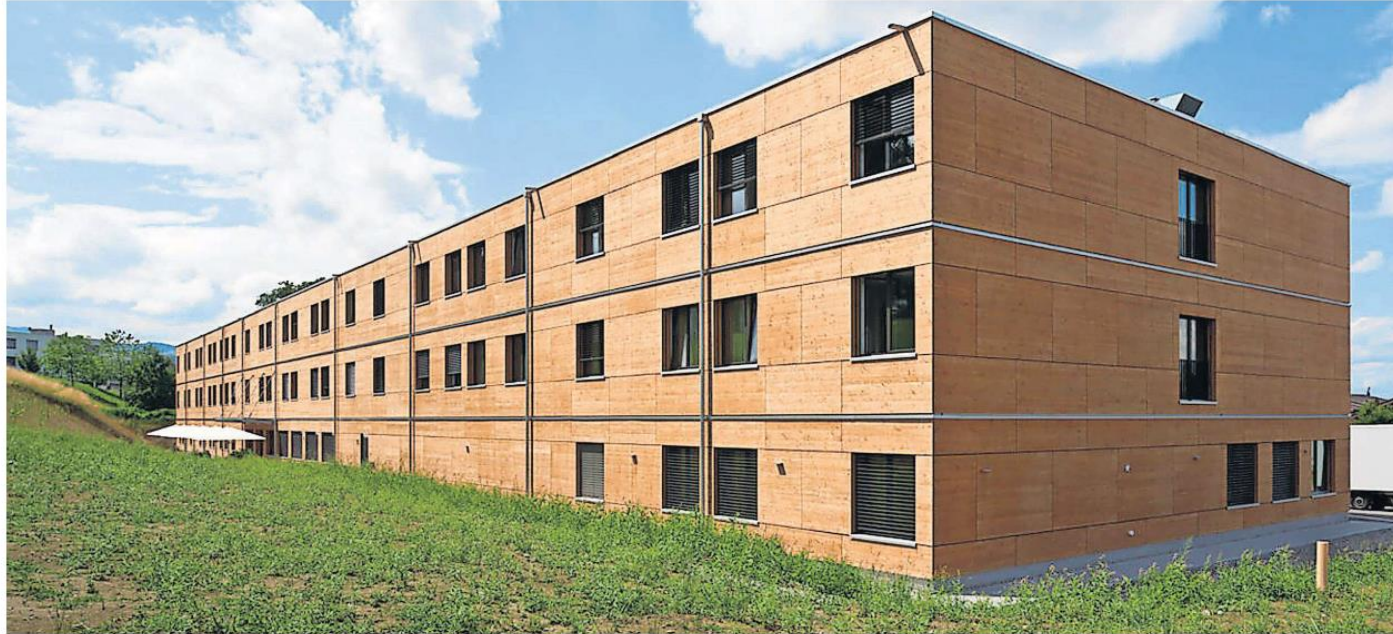
Inzwischen ist der Bau demontiert und wartet in einem Lager auf die Weiternutzung: Der Modulbau, den der Kanton Zug gekauft hat.
